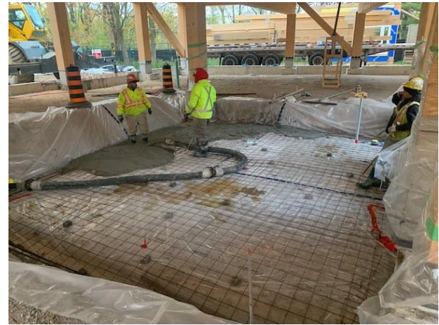
Ground Floor Concrete Pour
